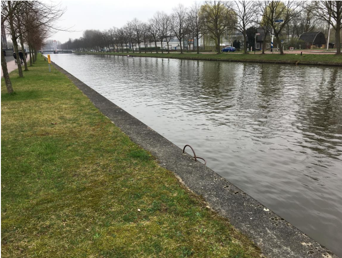
Aanlegplaats sloep (aanlegpaaltjes volgen nog)
